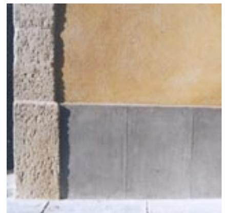
24 - Soubassement gris à la chaux hydraulique.
